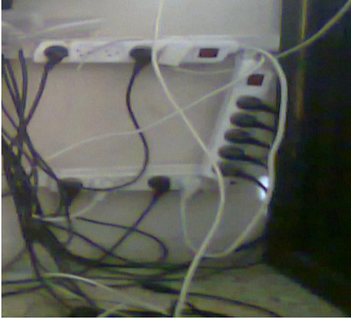
صورة رقم (2) : نموذج للاستخدام الخاطئ للموزعات
